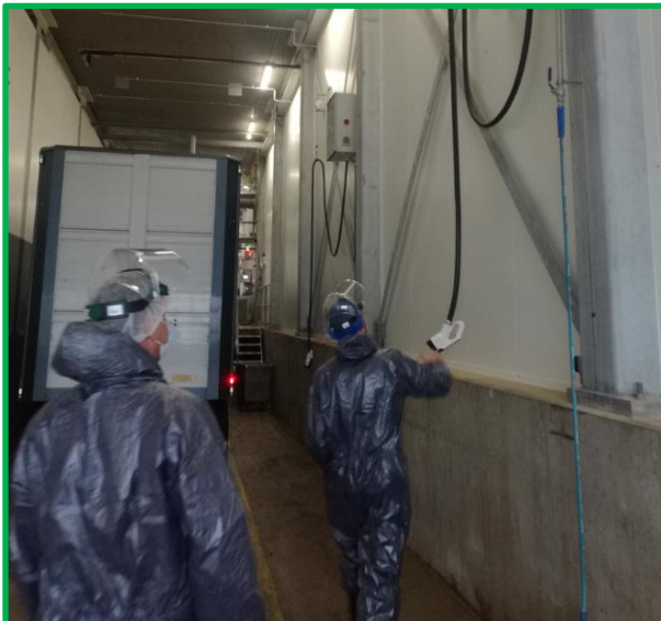
Zorg dat dwarsgeventileerde trucks hun ventilatiesysteem kunnen aansluiten op stroom. Dit is ook belangrijk in geval van pech met de motor of accu.
