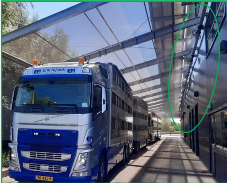
Ventilatoren met verneveling bij slachterij Westfort
