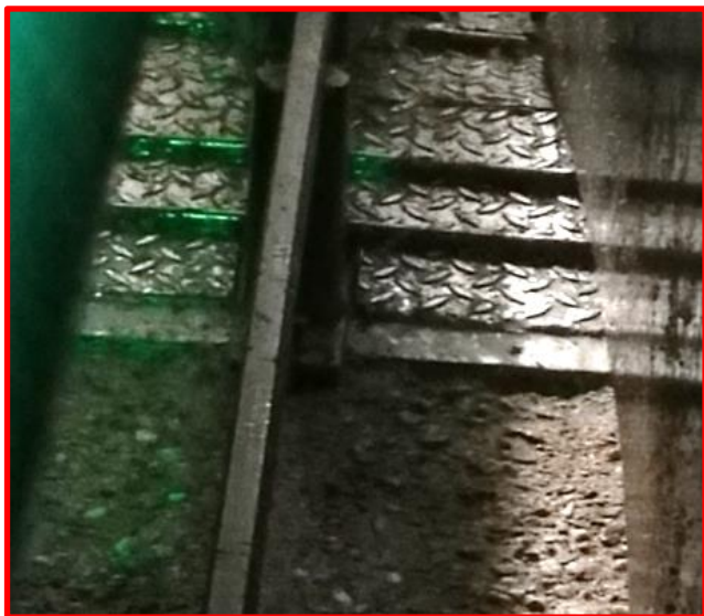
De overgang naar een andere kleur of materiaal vloer zorgt voor opstoppingen
