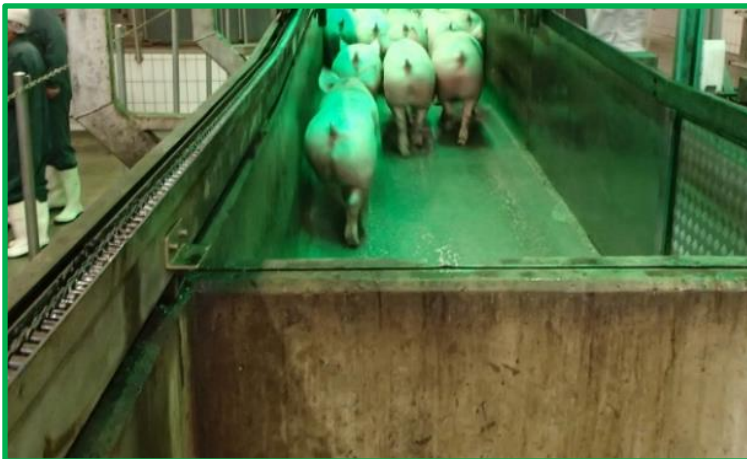
Door de gesloten en hoge wanden voorkom je dat varkens medewerkers naast de gang zien en worden afgeleid. Het groene licht vermindert schaduwen op de vloer.
