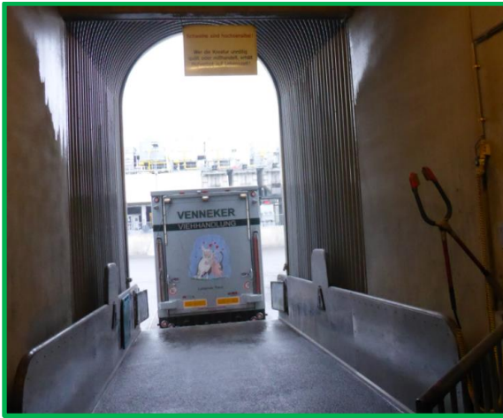
Maak de zijkanten van de laadbrug hoog en gesloten
