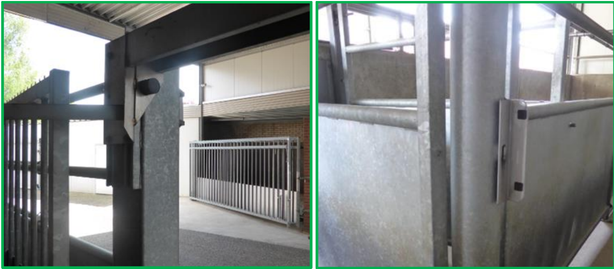
Het plaatsen van rubberen onderdelen, helpt harde geluiden bij het sluiten van hekken verminderen.
