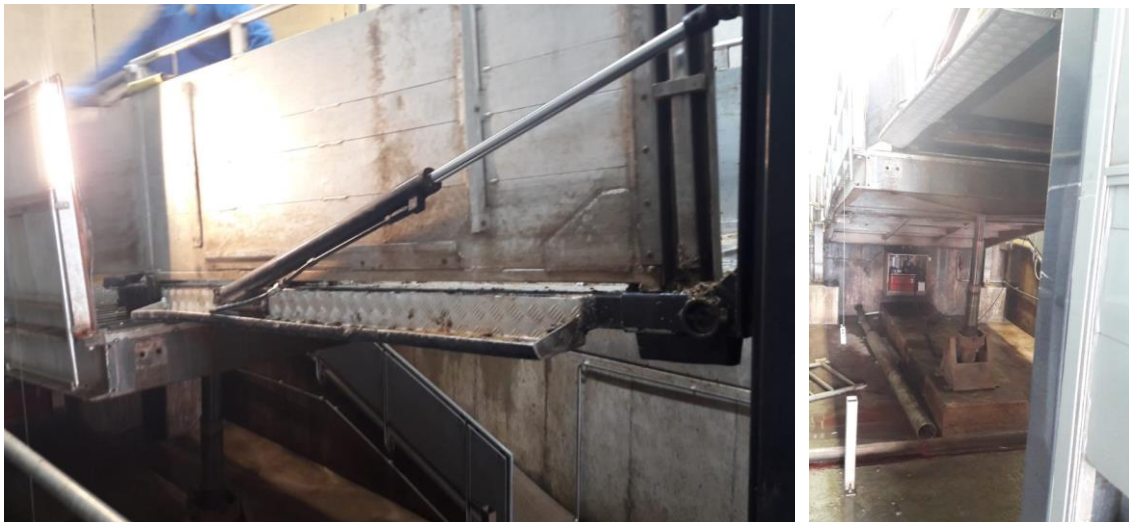
In hoogte verstelbare losbrug (hydraulisch)
