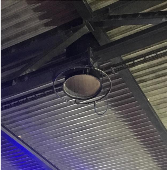
Ventilator met vernevelaar @GPS
