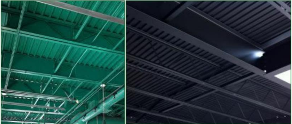
Plafonds met geluiddempend design en materiaal
